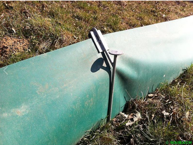
Photographie 34 et 35 : Exemples avec construction en porte-à-faux avec poteaux de retenue pour amphibiens et reptiles, coulés à 45° au-dessus pour protection antichute (Source : maibach.com)
