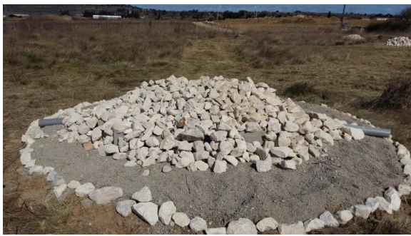
Recouvrement par des blocs de 100-200 Ø mm
