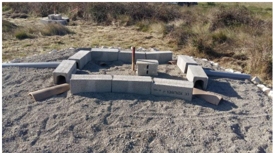
Mise en place du radier en graves concassées, des éléments constitutifs du gîte
