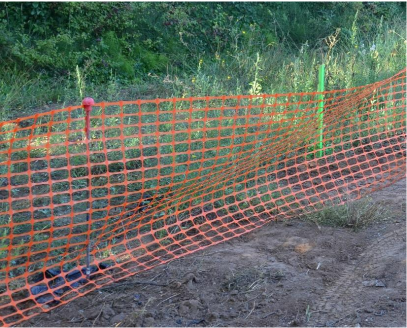
☞ Photographie 32 : Dispositif de limitation des emprises des travaux
