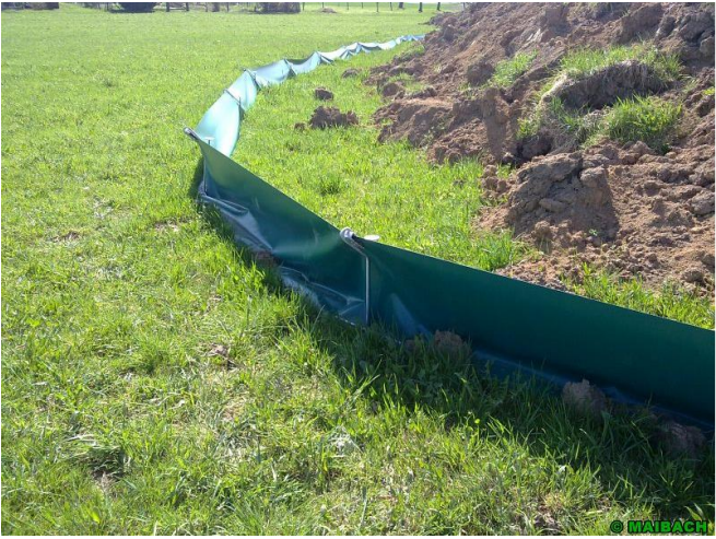
Photographie 34 et 35 : Exemples avec construction en porte-à-faux avec poteaux de retenue pour amphibiens et reptiles, coulés à 45° au-dessus pour protection antichute (Source : maibach.com)
