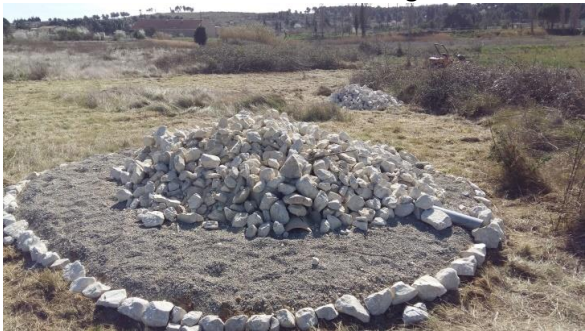
Recouvrement par des blocs de 100-200 Ø mm
